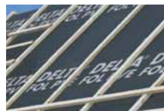
Чердачные или мансардные крыши с двухслойной вентиляцией.
