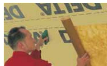
Пароизоляционная плёнка с ограниченной диффузией пара.
