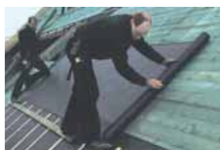
Крыши со сплошным настилом и двухслойной вентиляцией.
